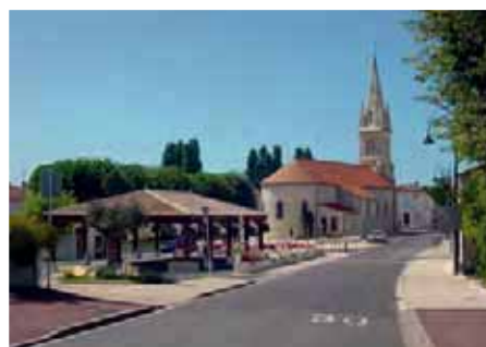
2004/2005 : Construction de la halle et aménagement autour de l'église
