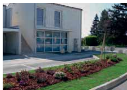
2007 : Construction de la poste et des logements locatifs aidés
