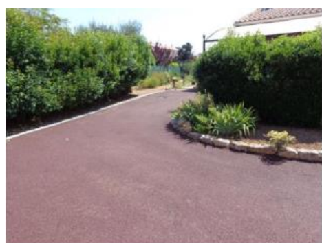
Allée/parking en enrobé poreux (source : Celtivia)
