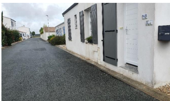
Chaussée à structure réservoir, rue de la Coquetterie à Mornac-sur-Seudre
