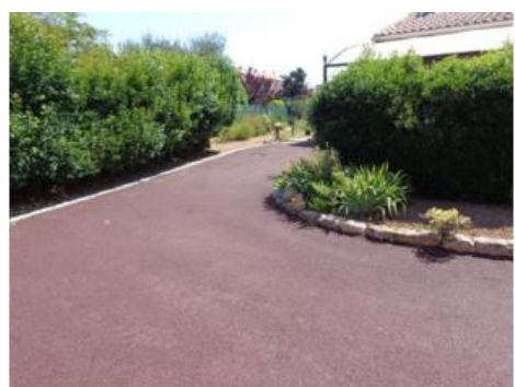
Allée/parking en enrobé poreux (source : Celtivia)
