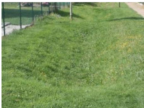
Noue en bordure d'allée (source : Alise Environnement)
